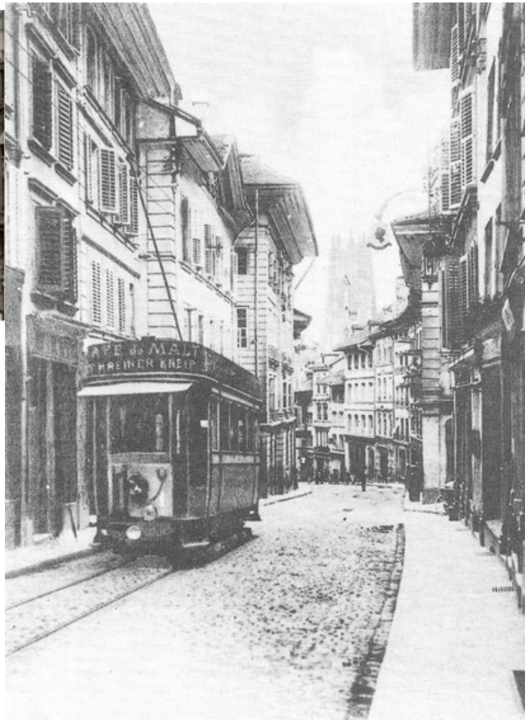
Avenue de la Gare dans les années 60 ci-dessus Et à droite la descente de la Rue de Lausanne en Direction de la Cathédrale / Place du Tilleul
